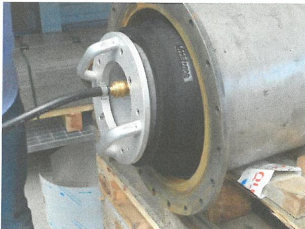
Bild 6: Aufstellen der Quick-Lock Linerendmanschette durch Packerdruck
