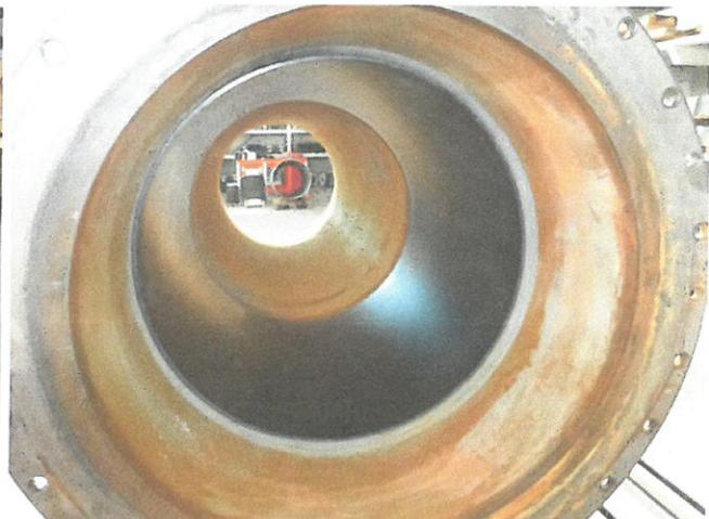
Bild 3: Stahlrohr ohne ZM-Auskleidung, Oberfläche Flugrost, eingeschobenes PE-Rohr als Liner
