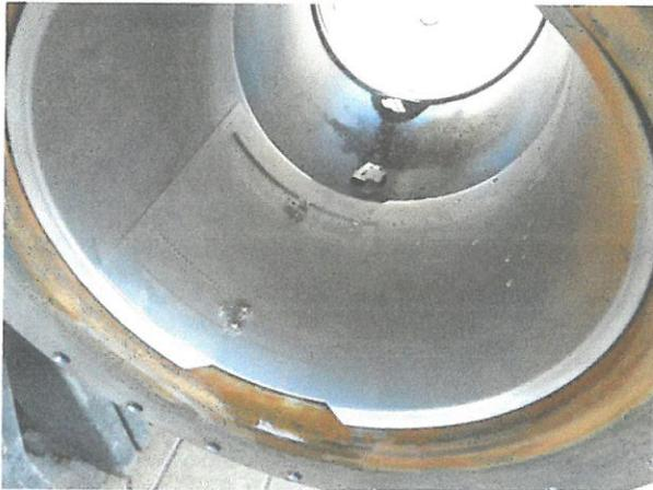
Bild 12: Öffnen der Rohre, Arretierungen abgeschlagen (im Hintergrund liegend)
